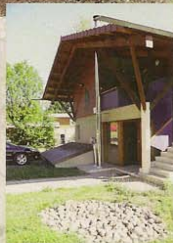
→ les puits d'infiltration
